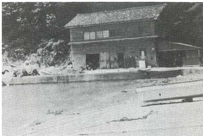
日本海中部地震による津波被害の様子 (舞鶴市野原港。5月27日12時15分。舞鶴海洋気象台撮影。 倉庫入口の半分の高さまで浸水の跡がある(暗色部)) 気象庁技術報告 第106号(1984年)より
