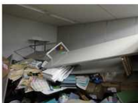
図 3 東京都内の同一ビルにおける低層階と高層階の被害状況（左：低層階 2 階 右：高層階 24 階）
