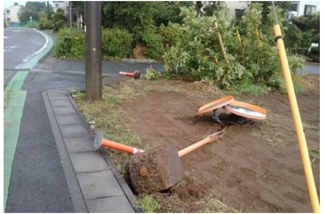
② 土台から倒壊したカーブミラー (東方向から撮影)
