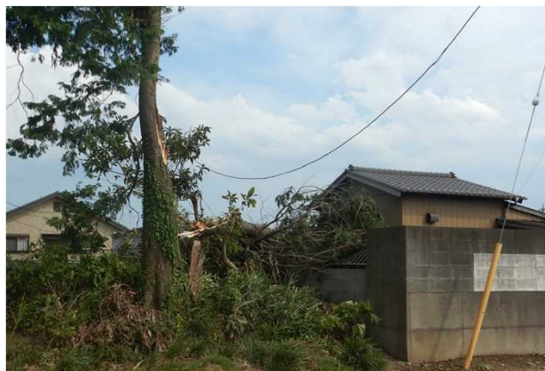
⑭ 樹木が折損しフェンスが壊れた住宅 (北西方向から撮影)
