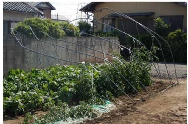
⑥ 鋼管が変形したパイプハウス (東方向から撮影)
