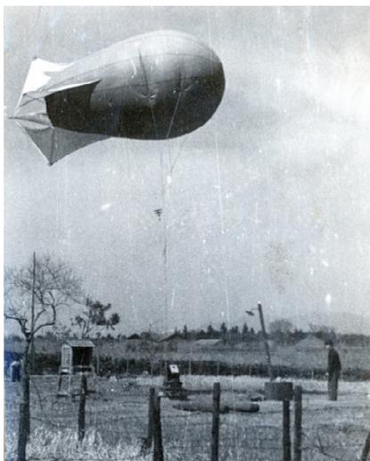
図 3.8.1 本庄出張所の係留気球と動力式線巻機
