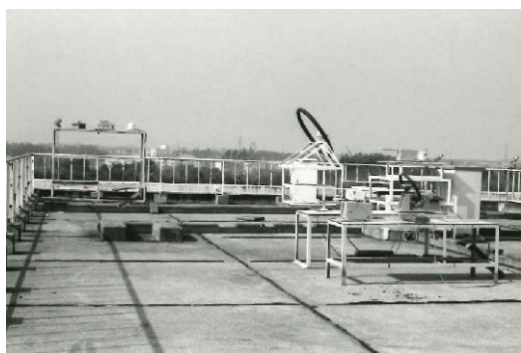
図 3.5.8 新庁舎屋上の観測風景
