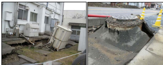
地盤沈下による水槽の傾き 歩道の陥没・マンホールの浮上 (出典：気象庁 災害時地震・津波速報)
