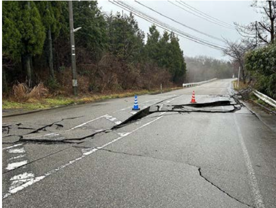
写真8-1：道路の亀裂
