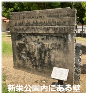
気象台の西壁の一部
