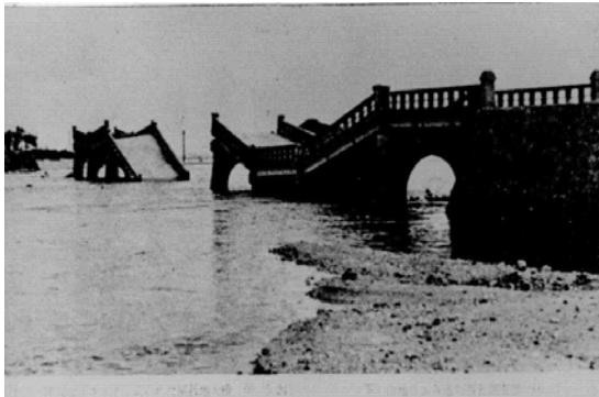
「津波により破壊された屋我地大橋」 (沖縄タイムス提供)
