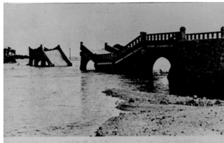
〔津波により破壊された屋我地大橋〕 （沖縄タイムス提供）
