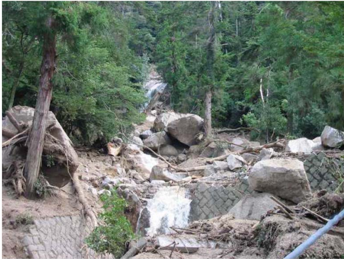
①六角堂裏から上流の砂防堰堤を望む
