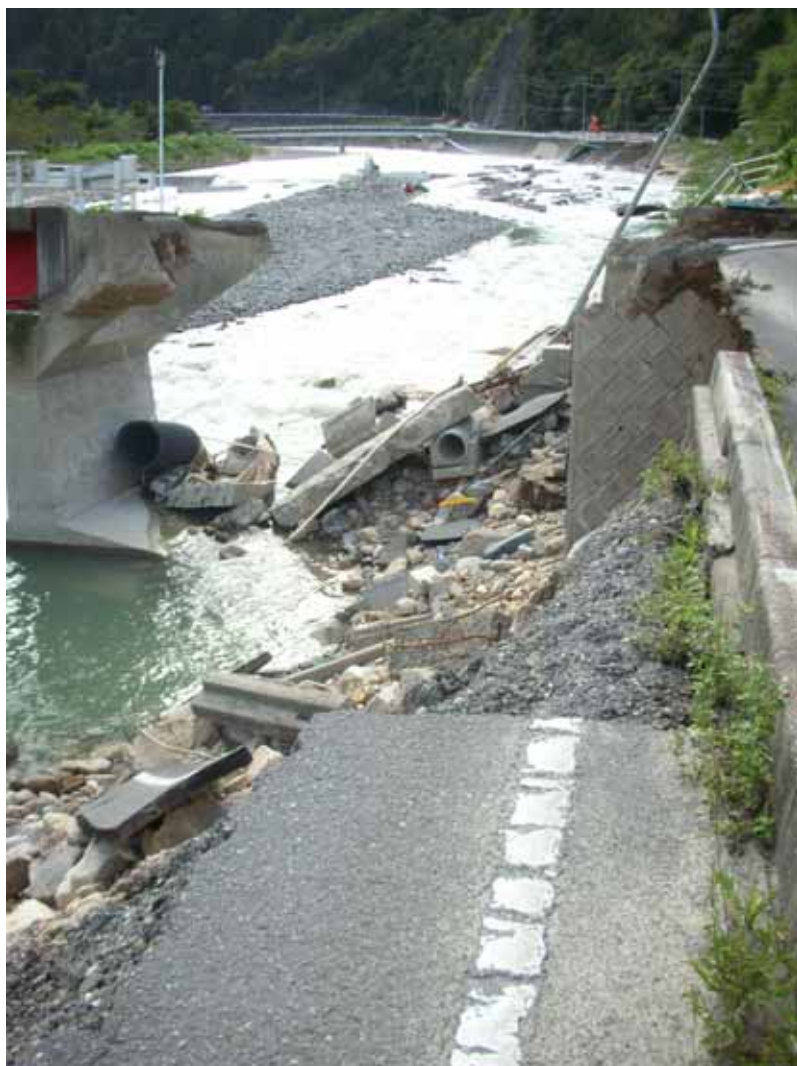
水内川に架かる橋の流失（佐伯区湯来町麦谷地区）
