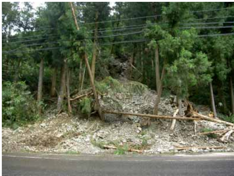
国道433号脇の斜面からの土砂流出。
