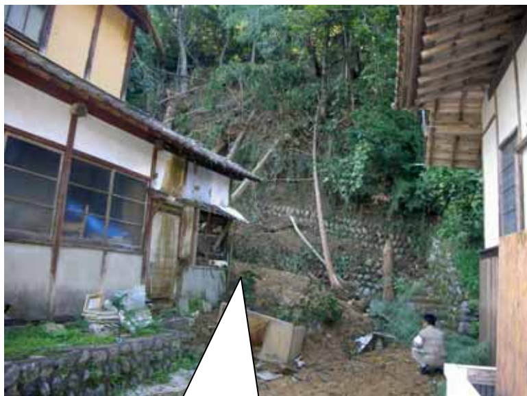
湯来町堂原（麦谷郵便局近く） 空き家裏の土砂崩れ。
