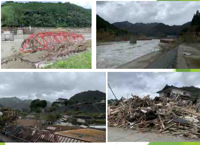
災害現地調査 球磨川流域 (2020年07月25 - 26日 : 災害発生約3週間後) 熊本県球磨村・人吉市
