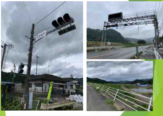
災害現地調査 球磨川流域 (2020年07月25 - 26日 : 災害発生約3週間後)
