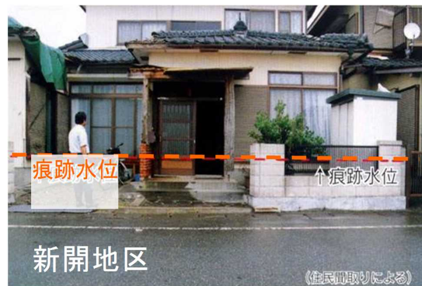
しんかい 新開地区浸水状況 （八代市新開町）
