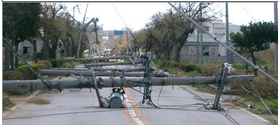
平成15年の台風第14号の被害
