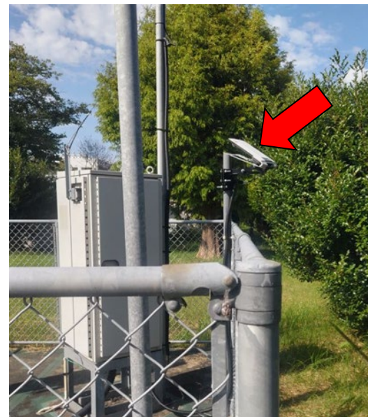
可搬型通信装置(アンテナ) を設置したところ
