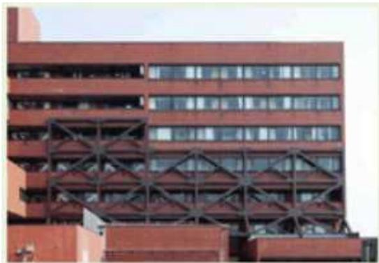
耐震改修の一例：外付け鉄骨フレーム
