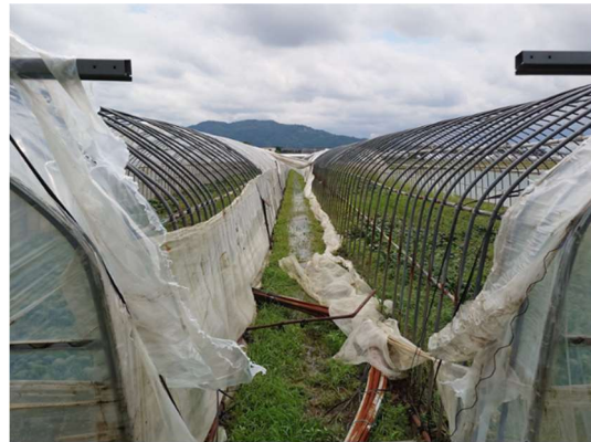
④ 農業用ハウス被覆材のはく離
