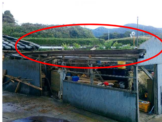
② トタン屋根の剥がれ
