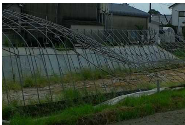
②鋼管が変形したパイプハウス
