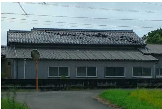
①屋根瓦がめくれた住家
