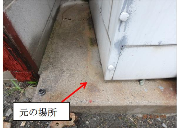
写真2 住家のずれた温水器
