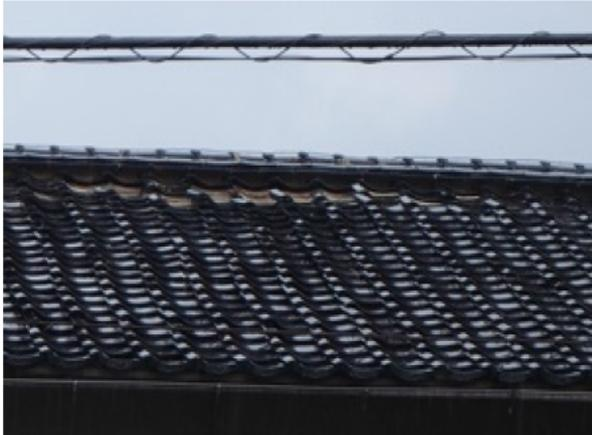
写真1 住家の屋根瓦の損壊
