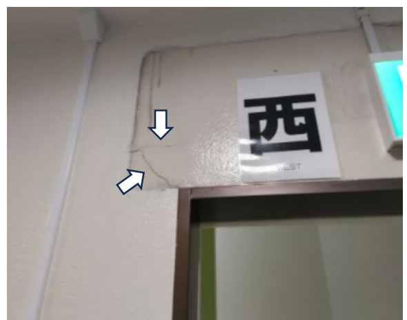
写真8 壁の亀裂
