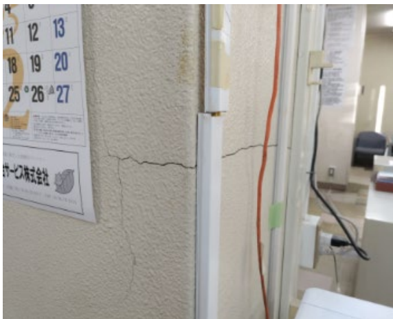
写真7 壁の亀裂
