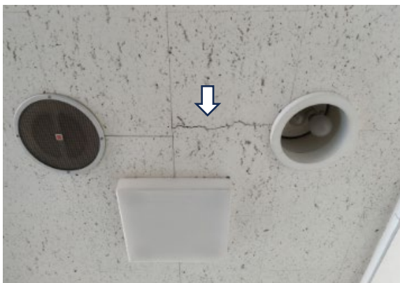
写真9 天井の亀裂
