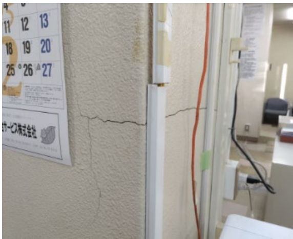
写真7 壁の亀裂
