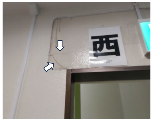
写真8 壁の亀裂
