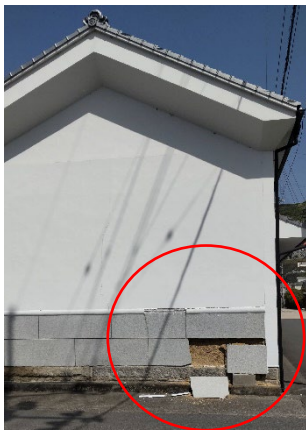
写真3 土壁の破損
