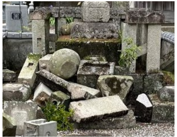
写真6 石灯籠の倒壊
