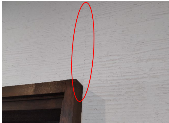
写真4 壁のひび
