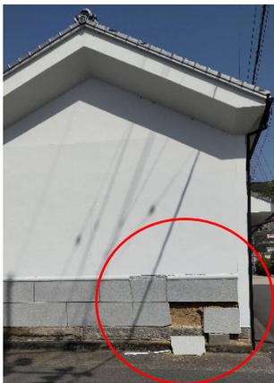
写真3 土壁の破損
