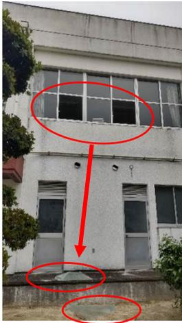
写真1 体育館の窓ガラスの破損
