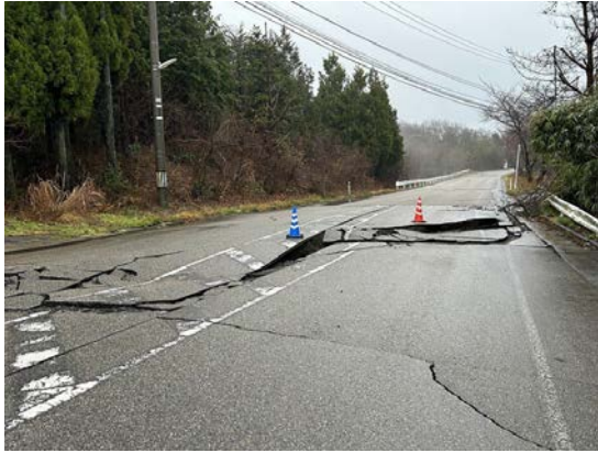
写真8-1：道路の亀裂
