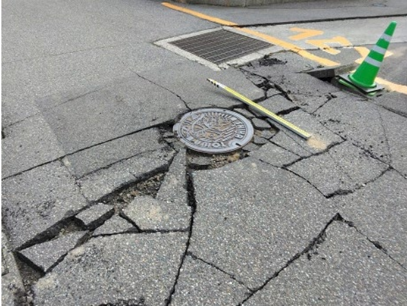
写真8-7：道路の亀裂
