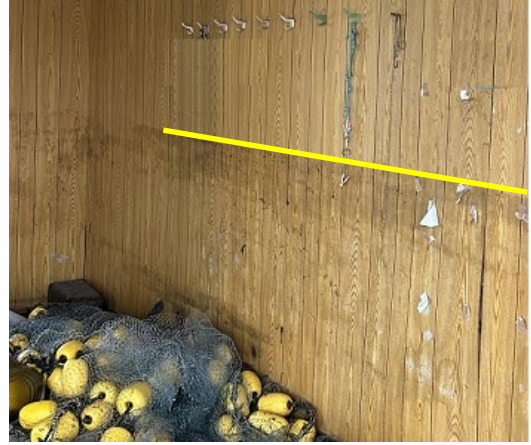
写真8-14：津波の痕跡（珠洲市鵜飼漁港）
