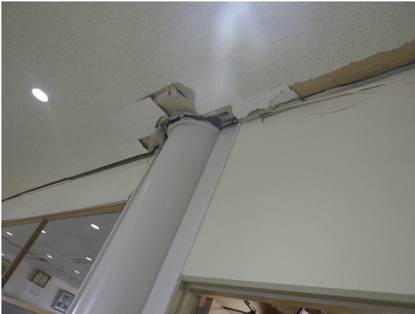
写真3：天井の破損
