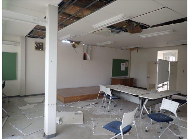
写真4：天井の破損
