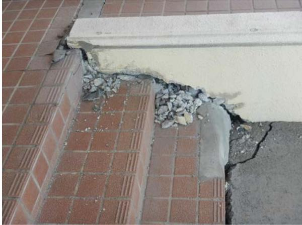
写真1：建物入口階段の破損
