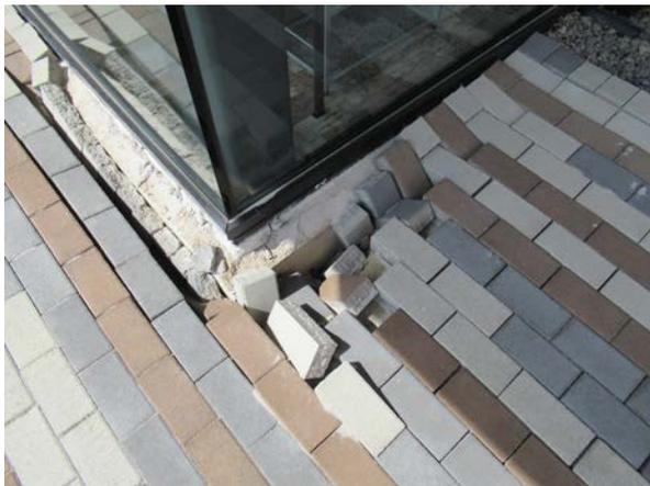
写真7：歩道ブロックの破損
