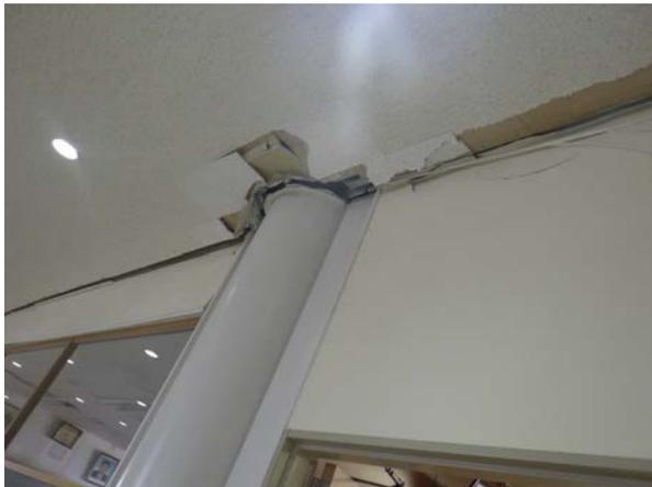
写真3：天井の破損
