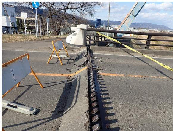
写真10：橋梁接合箇所の破損
