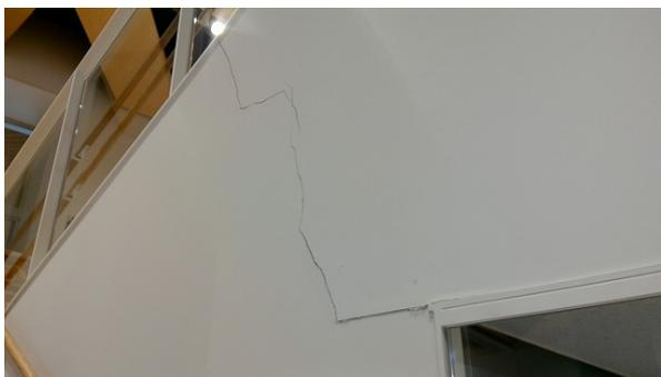
写真9：階段壁面ボードの亀裂
