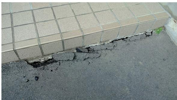
写真11：建物入り口のアスファルト破損
