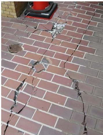
写真5：建物入り口タイル床面の破損
