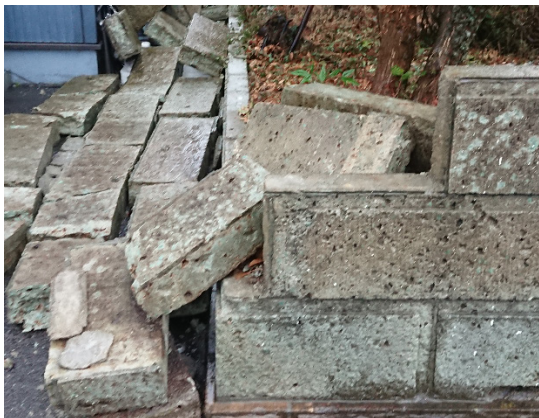
写真7-19 民家の塀の倒壊
