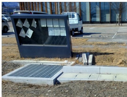
写真7-15 役場敷地内の屋外掲示板の傾き
