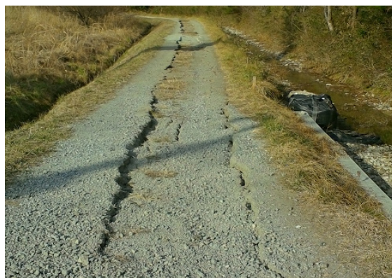
写真7-7 農道の亀裂
