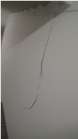
写真7-8 階段の壁に亀裂
