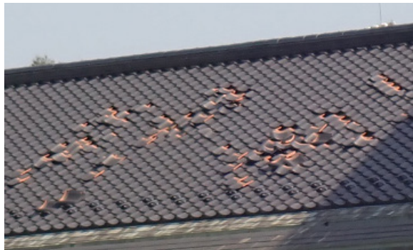
写真7-34 瓦のずれ
