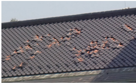
写真7-34 瓦のずれ
