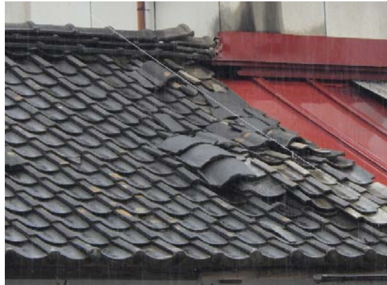
写真7-22 瓦のずれ
