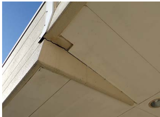
写真7-29 外壁の亀裂
