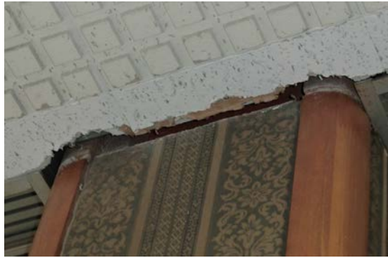
写真7-33 天井の破損
