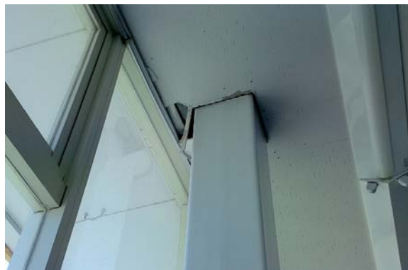
写真7-25 天井の破損
