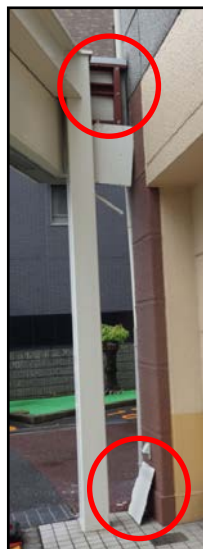
写真8 看板の破損
