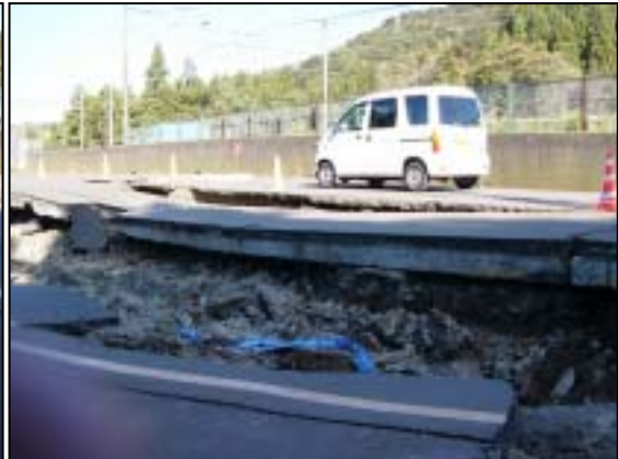
写真2-7 道路の崩落（崩落した道路の長さは約50mで落差は約2m）
