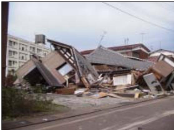
写真 2-13 倒壊した 2 棟の家屋
