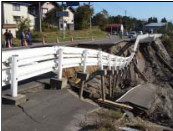
写真2-8 道路・鉄道の崩落（国道17号とJR上越線）
