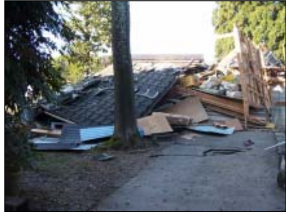
写真 2-10 全壊した家屋
