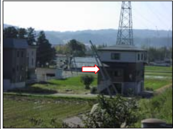
写真 2-2 傾いた電柱（小千谷 IC 付近）
