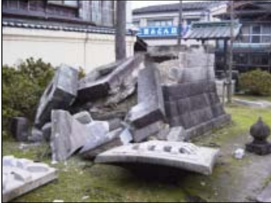
写真2-5 灯籠の倒壊 【小千谷震度観測点から約560m】
