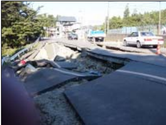
写真2-7 道路の崩落（崩落した道路の長さは約50mで落差は約2m）
