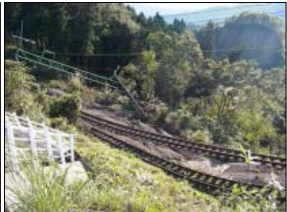
写真2-8 道路・鉄道の崩落（国道17号とJR上越線）
