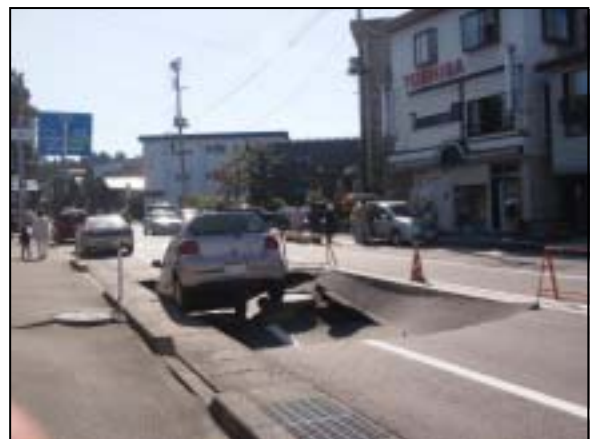
写真 2-4 道路上の陥没箇所（陥没は深さ 50cm 長さ 7m50cm 程度。）【小千谷震度観測点から約 250m】
