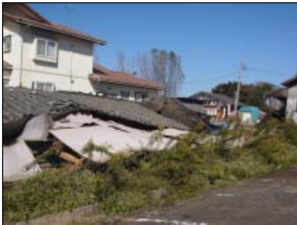
写真 2-3 全壊した手前の家屋と外見上被害が見られない後ろの家屋【小千谷震度観測点から約 100m】
