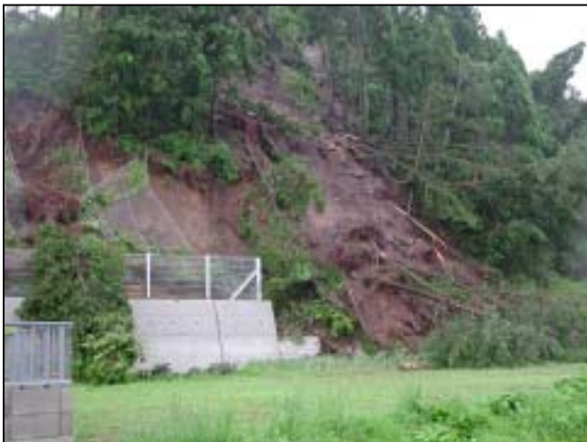
鳴瀬町町役場付近(2003.07.26) 崖崩れ
