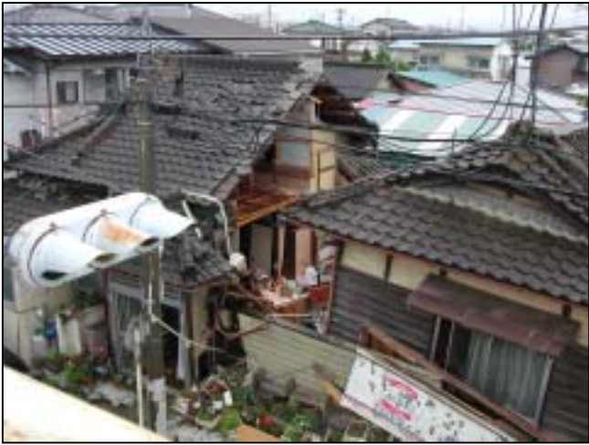
矢本町 (2003.07.26) 民家の倒壊
