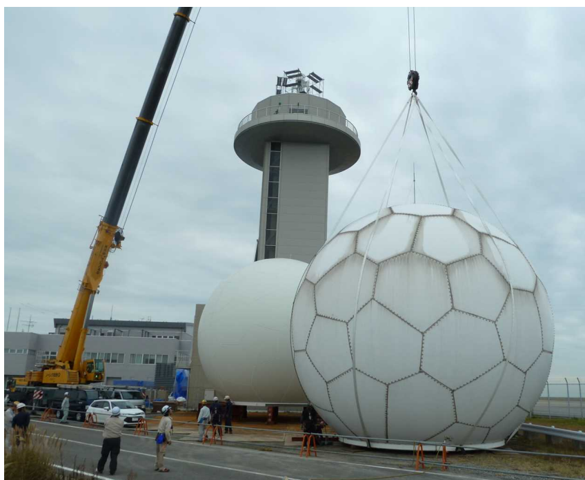
セントレアに設置されている空港気象ドップラーレーダーのレドーム交換の様子
