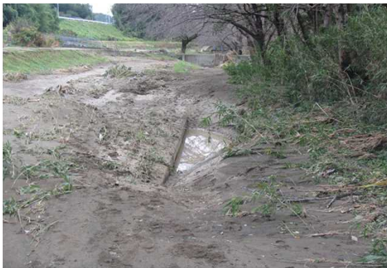
写真3 高崎市吉井町(鎗川馬庭堰、農業用水路の土砂堆積)
