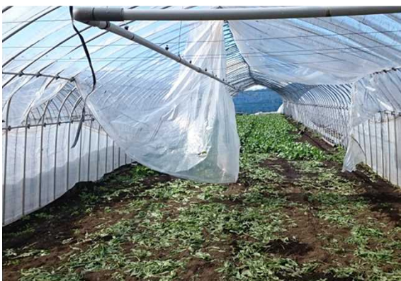
写真5 高崎市(ピニールが剥がれ落ちた農業用ハウス)
