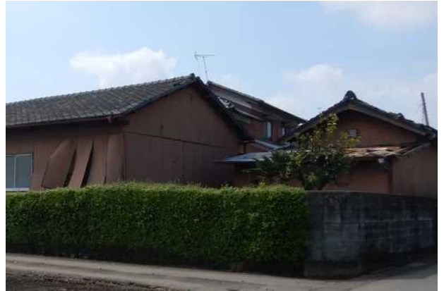
外壁と庇の屋根がめくれた非住家 (東北東方向から撮影)
