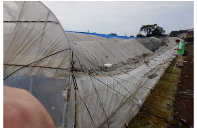
半壊したパイプハウス (東方向から撮影)
