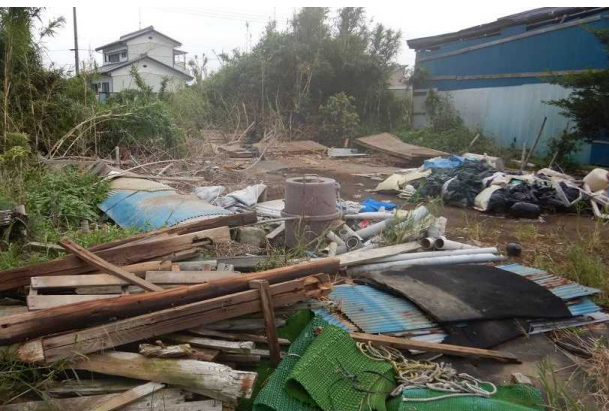
飛散し全壊した非住家 (北西方向から撮影)
