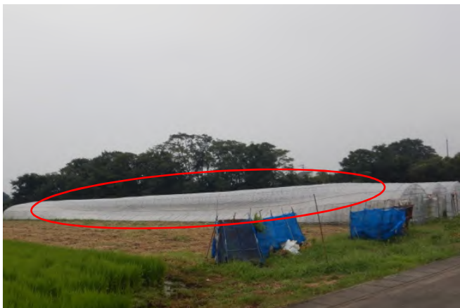
鋼管が変形したパイプハウス (北西方向から撮影)
