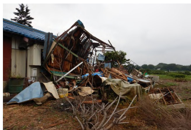
転倒したプレハブ小屋 (東方向から撮影)
