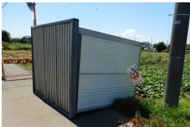
転倒した物置小屋 (北方向から撮影)
