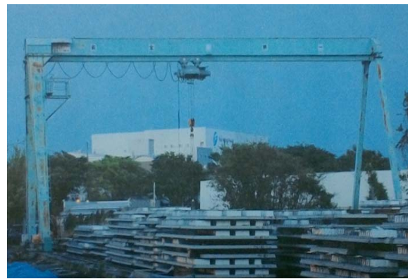
⑥ 移動したクレーン （西から撮影）
