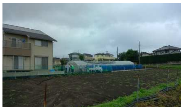
ビニールがはく離れたパイプハウス (西から撮影)
