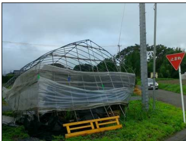
変形したパイプハウス、一部修復済 (上里町) (北東から撮影)
