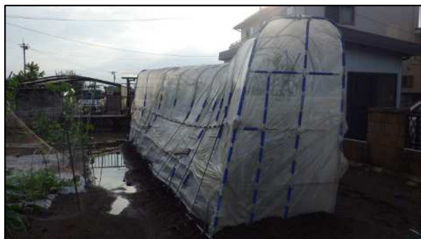
鋼管が変形したパイプハウス （東から撮影） 提供：伊勢崎市消防本部
