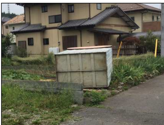
転倒したプレハブ小屋 （北から撮影）
