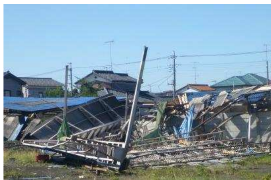
倒壊した資材倉庫 (埼玉県行田市下池守)
