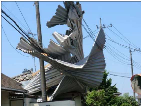
③ 飛ばされて落下した折板屋根 （栃木県足利市：東から撮影）
