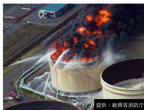
図3 大型タンク類の被害
