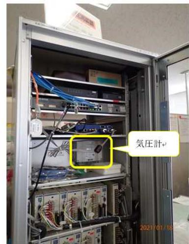
図1.気圧計の設置場所（気象台現業室のJMA-10型地上気象観測装置）
