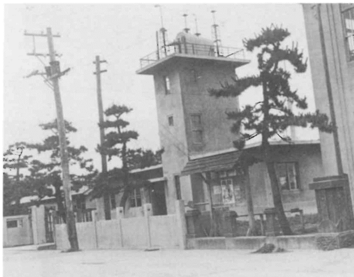
写真 2 青森測候所（油川庁舎）（撮影時期不明）
