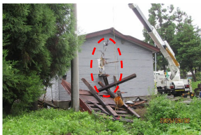
④非住家の壁破損(北西から撮影)
